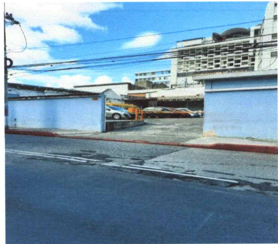
Antigua sede de la Escuela nacional de artes Plásticas. BMYF, edificio destruido por el terremoto. En la actualidad es un parqueo público.
